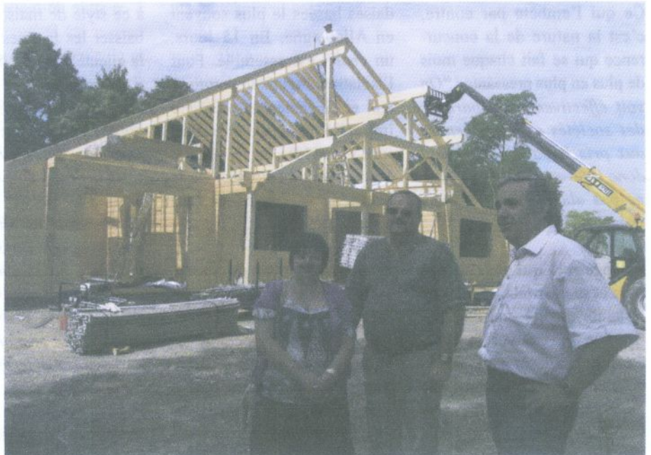
M. et Mme Harbonnier et Philippe Stivala (à droite) assistent au montage de la première maison finlandaise de Nœux-les-Mines.
