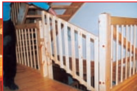
Finnische Lösung: Die einfach konstruierte Treppensicherung wird angehoben und dann beiseite geschwenkt.
