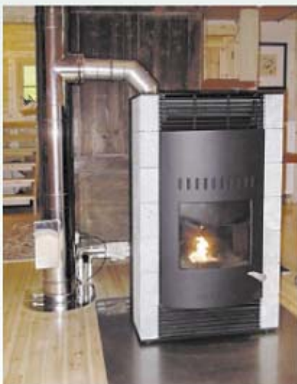
Der 10 kW-Pellets-Ofen wird mittels Raumluftthermostat gesteuert.
