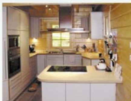
Hängeschränke an den setzenden Außenwände und setzfreien Innenwände.
